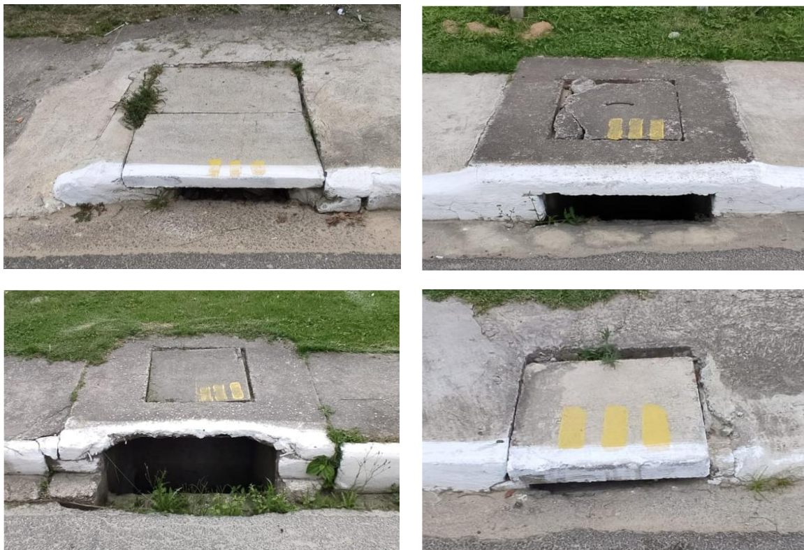
Figura 80 – Componentes do sistema de drenagem pluvial existentes nas ruas de entorno do empreendimento. Fonte: Autor, 2026.
